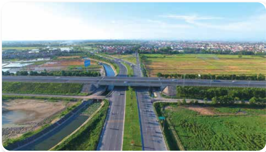
Hình 3. Đường cao tốc Hà Nội – Hải Phòng đoạn qua thành phố Hải Dương
